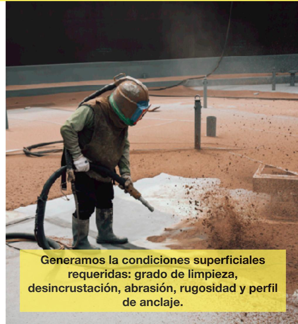
**Generamos la condiciones superficiales requeridas: grado de limpieza, desincrustación, abrasión, rugosidad y perfil de anclaje.**
